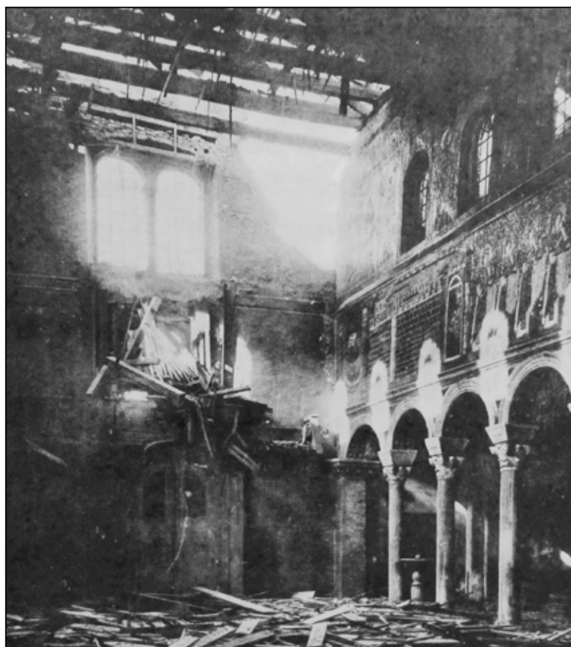
Interno della Basilica dopo il bombardamento (Tavole Storiche di C. Ricci, fascicolo IV, p. 115)
